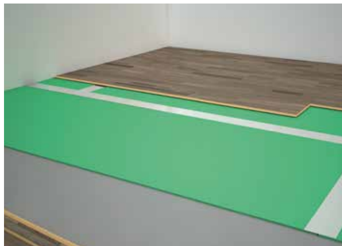
Installatie MAGNUM Isofoam
